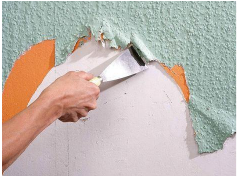
Рисунок 7.7 – Ремонт шпалерних покриттів
