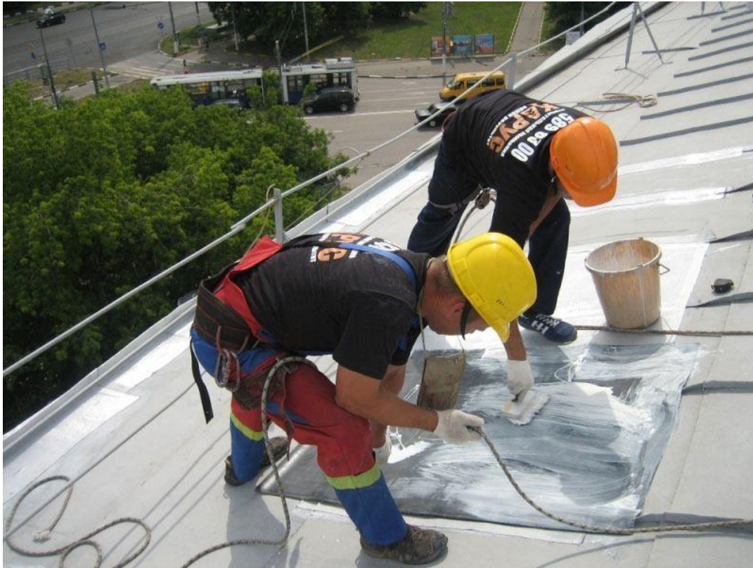
Рисунок 4.1 – Ремонт окремих пошкоджень покрівель
