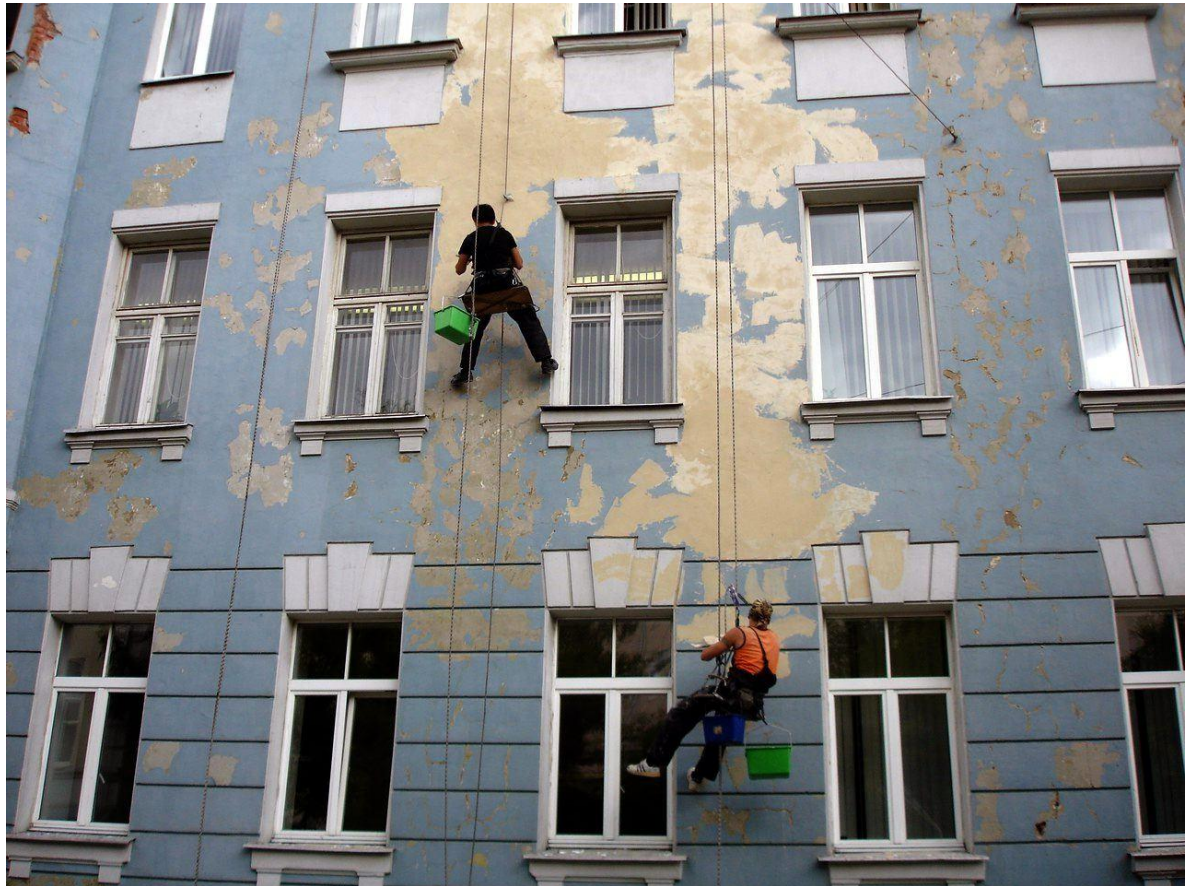
Рисунок 7.3 – Ремонт малярних покриттів фасадів
