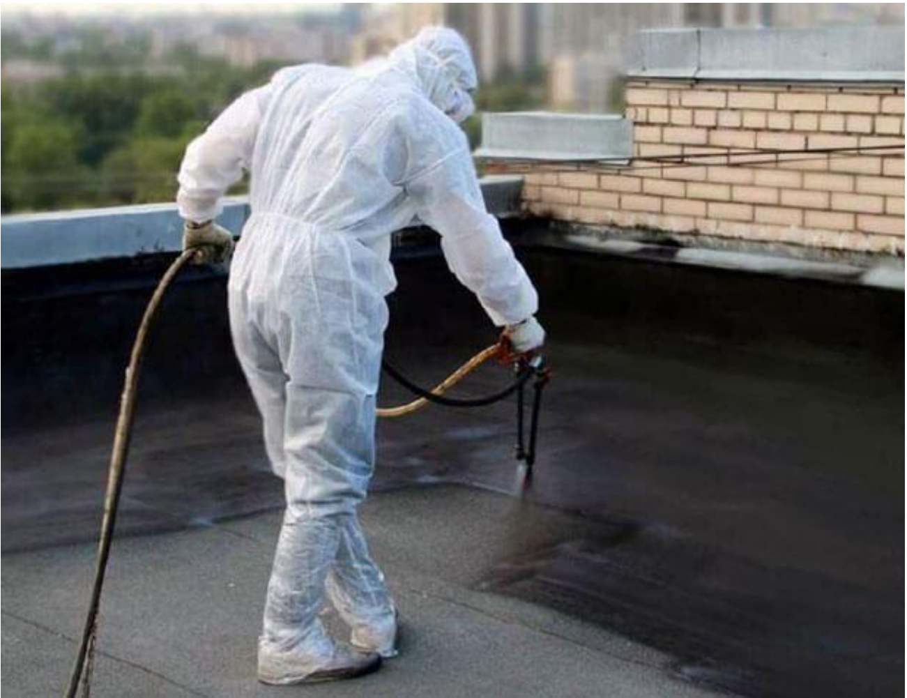
Рисунок 4.4 – Нанесення мастики за допомогою вудки-розпилювача
