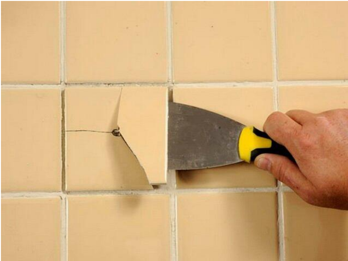
Рисунок 7.5 – Ремонт внутрішнього облицювання стін
