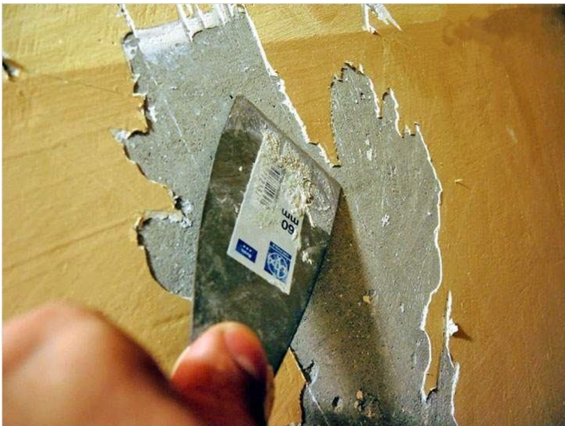
Рисунок 7.6 – Видалення пошкодженого забарвлення стін
