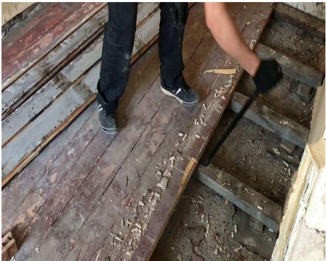
Рисунок 8.8 – Розбирання дощатої підлоги
