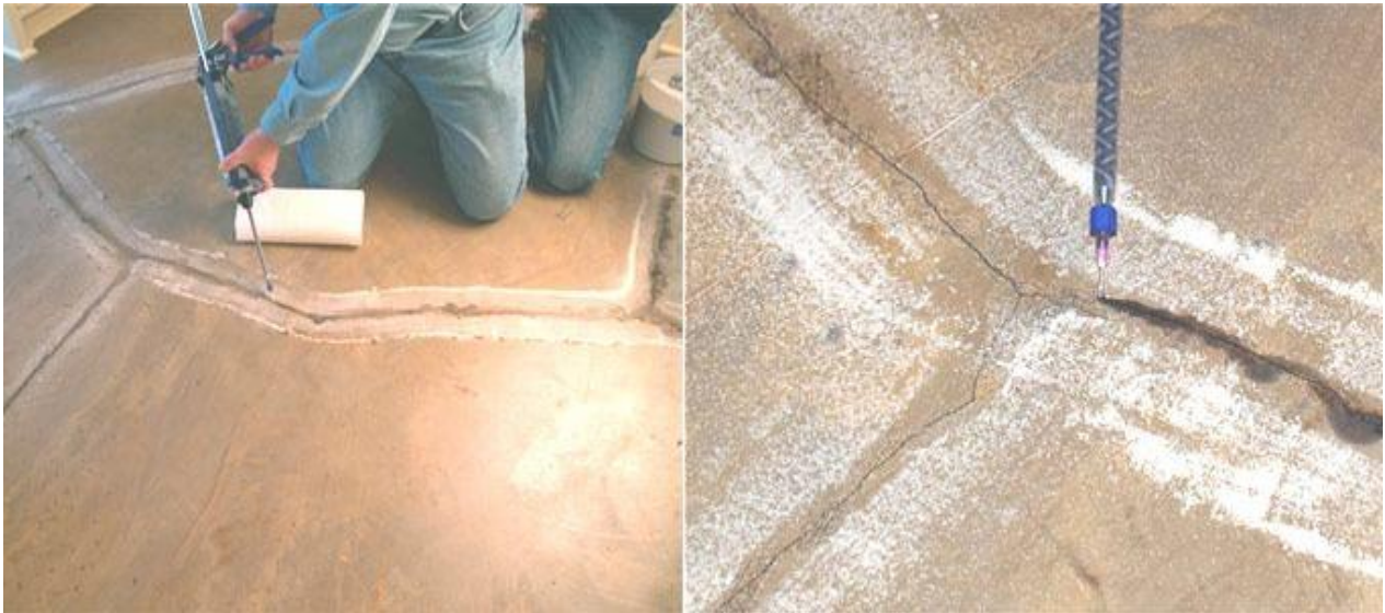
Рисунок 7.10 – Відновлення монолітних підлог
