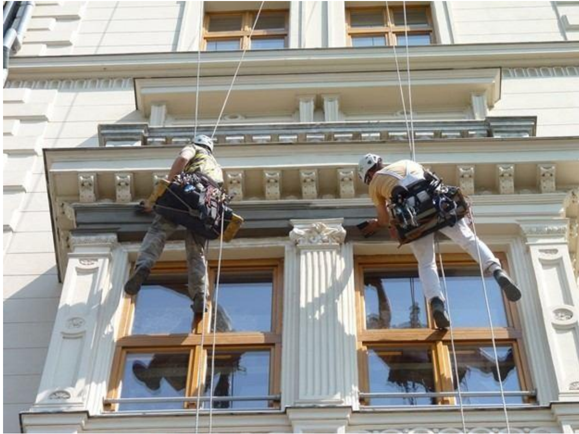
Рисунок 7.1 – Ремонт штукатурки стін фасадів
