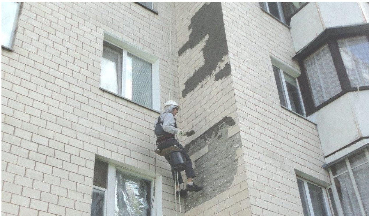
Рисунок 7.2 – Ремонт облицювання фасадів
