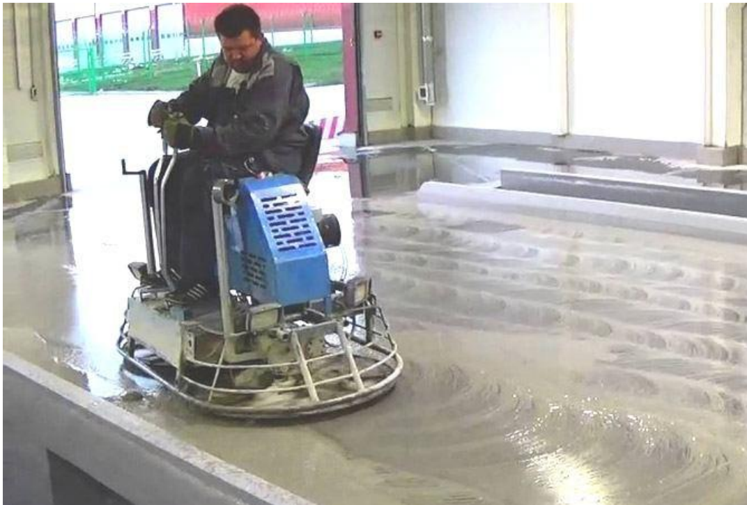
Рисунок 7.11 – Шліфування поверхні монолітних підлог оздоблювальними машинами
