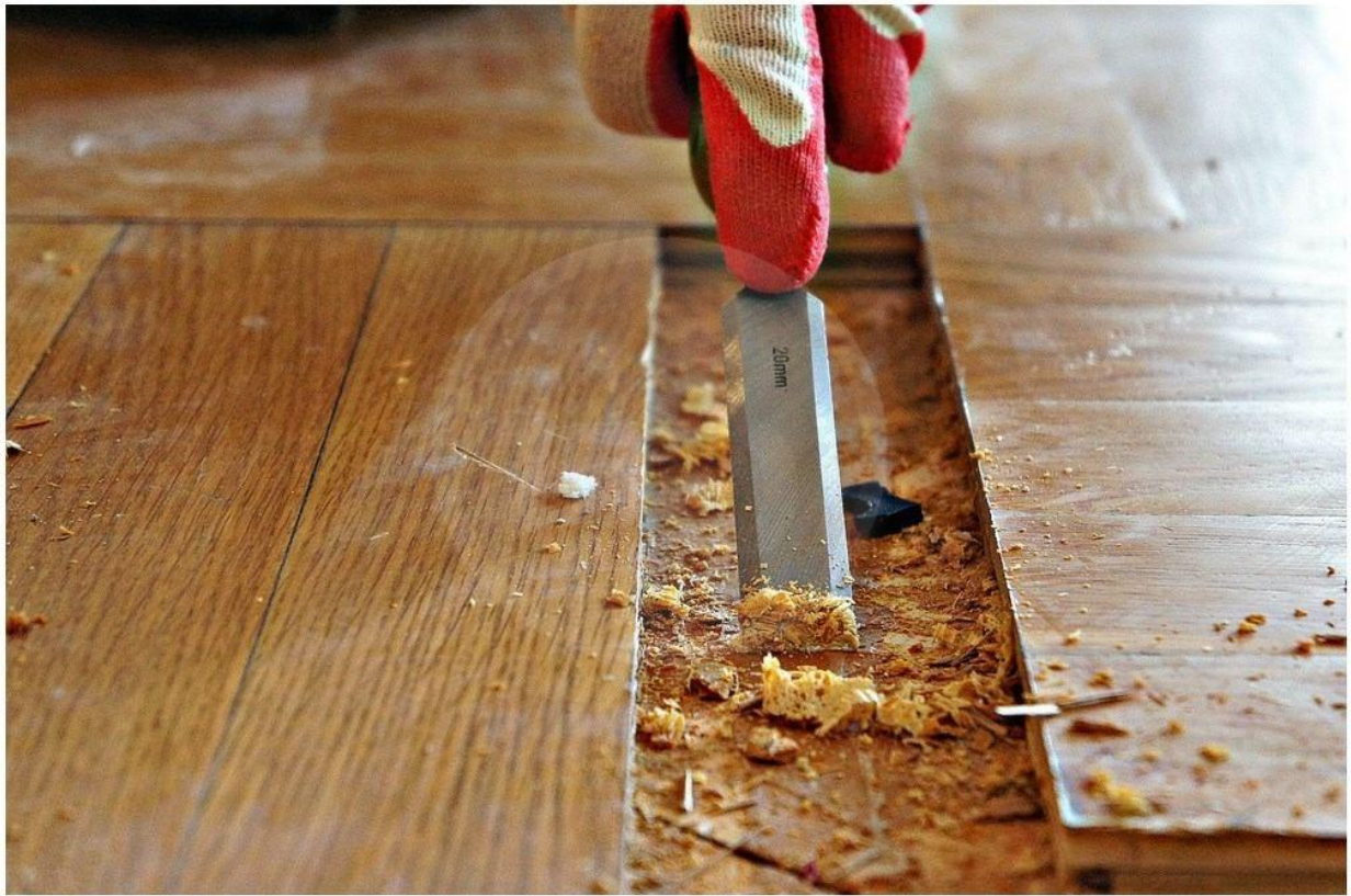
Рисунок – Ремонт паркетних підлог
