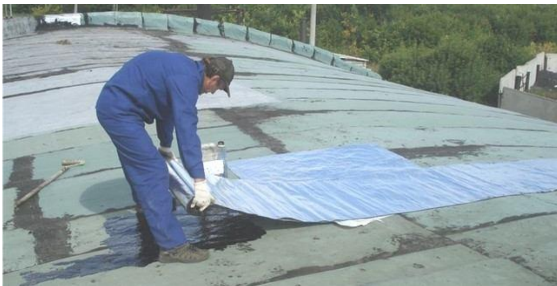
Рисунок 4.2 – Латочний ремонт покрівель із рулонних матеріалів
