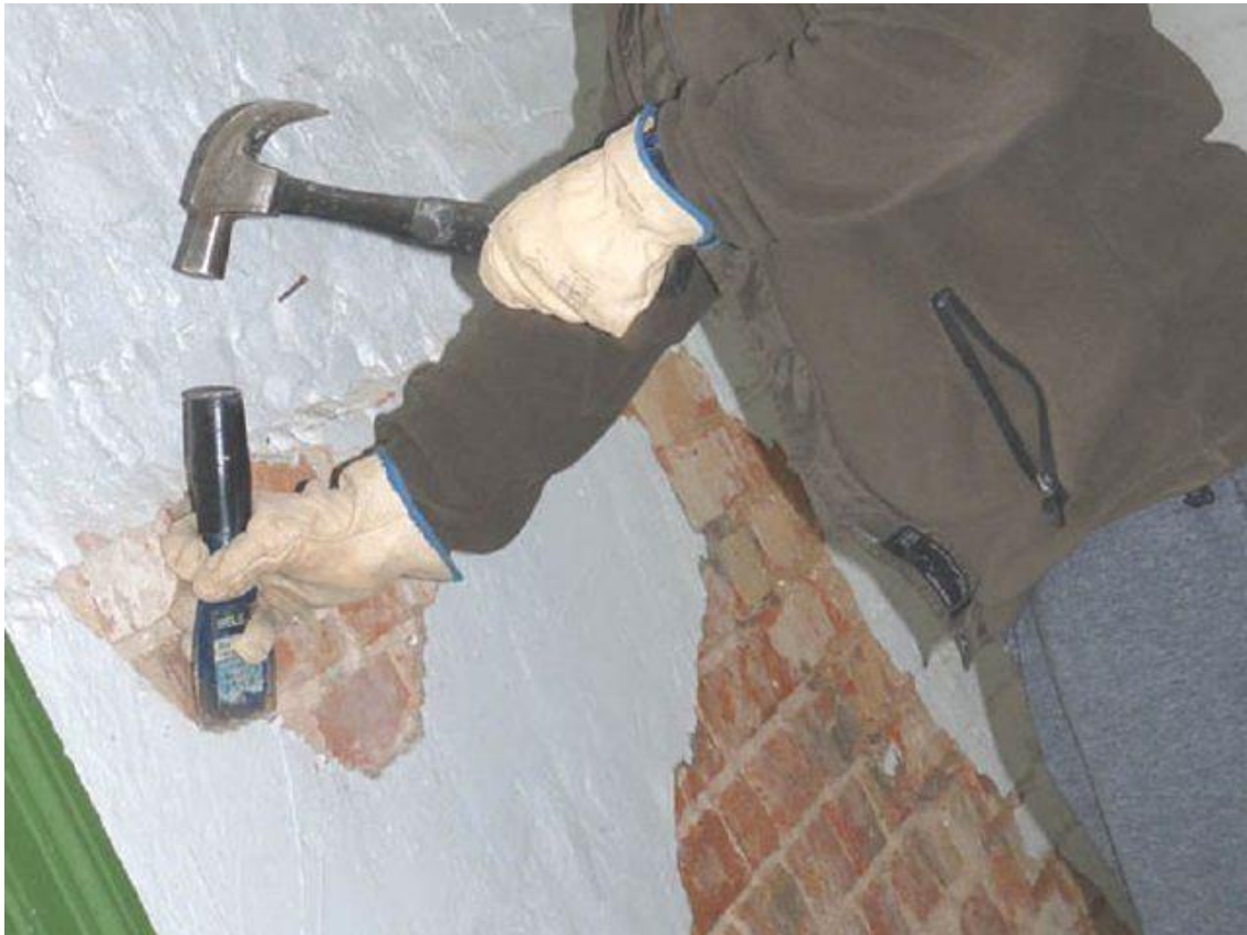
Рисунок 7.4 – Ремонт внутрішньої штукатурки стін
