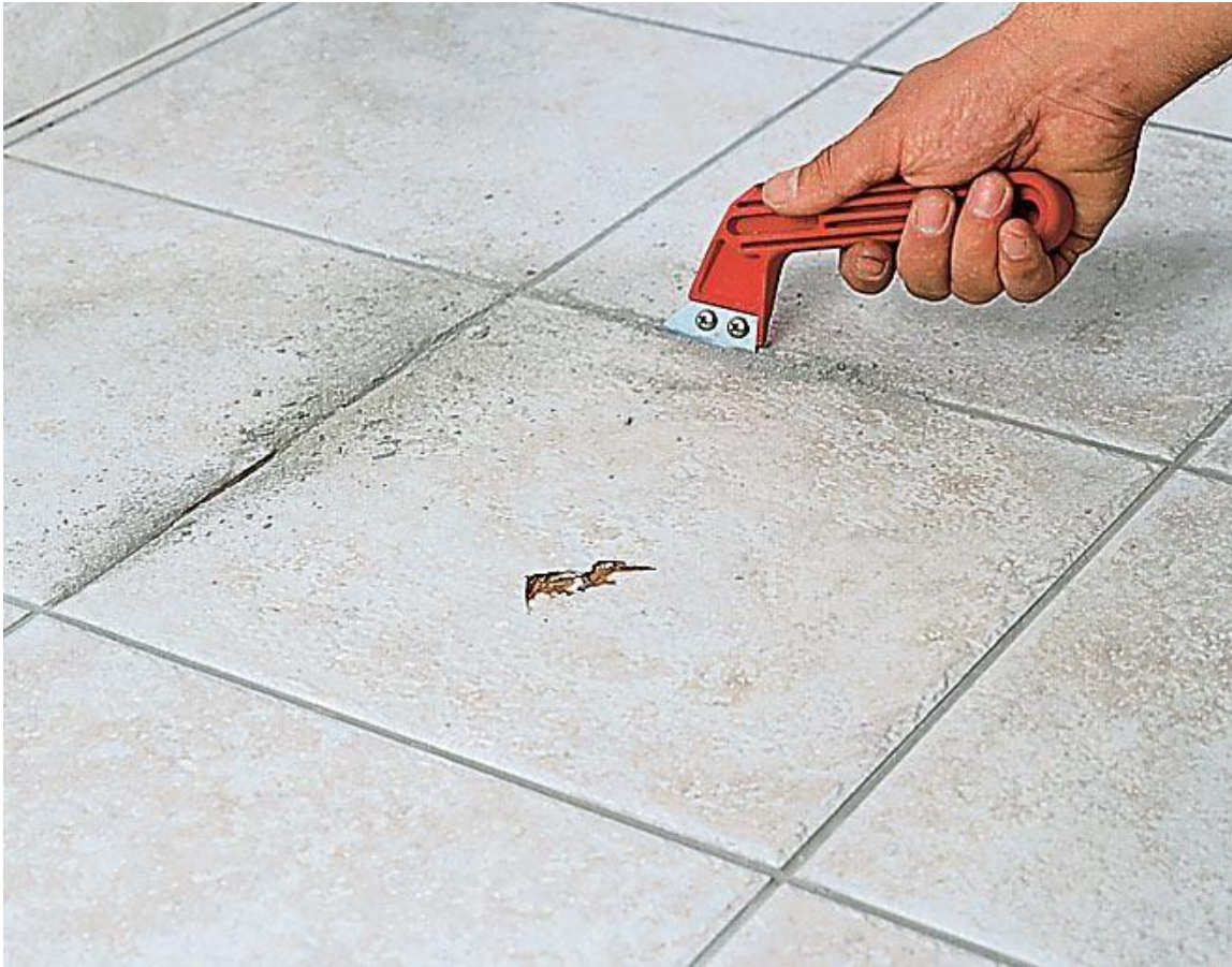
Рисунок 7.12 – Ремонт покриттів з штучних матеріалів
