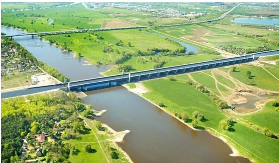
Мости бувають не тільки пішохідними, автомобільними або залізничними. Знайомтеся - Магдебурзький водний міст. По цьому технічному чуду завдовжки кілометр ходять різні судна - баржі, пороми, прогулянкові катери. Цей довжелізний водний міст світу сполучає між собою два судноплавних канали - Ельба-Хафель і Середньо германський канал.
